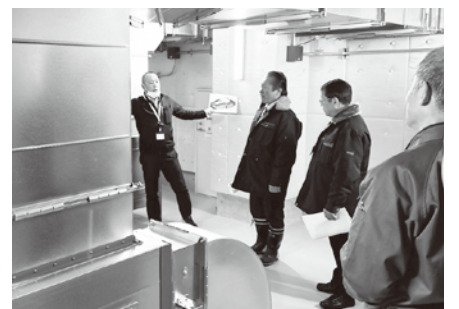
浮塚排水機場視察
